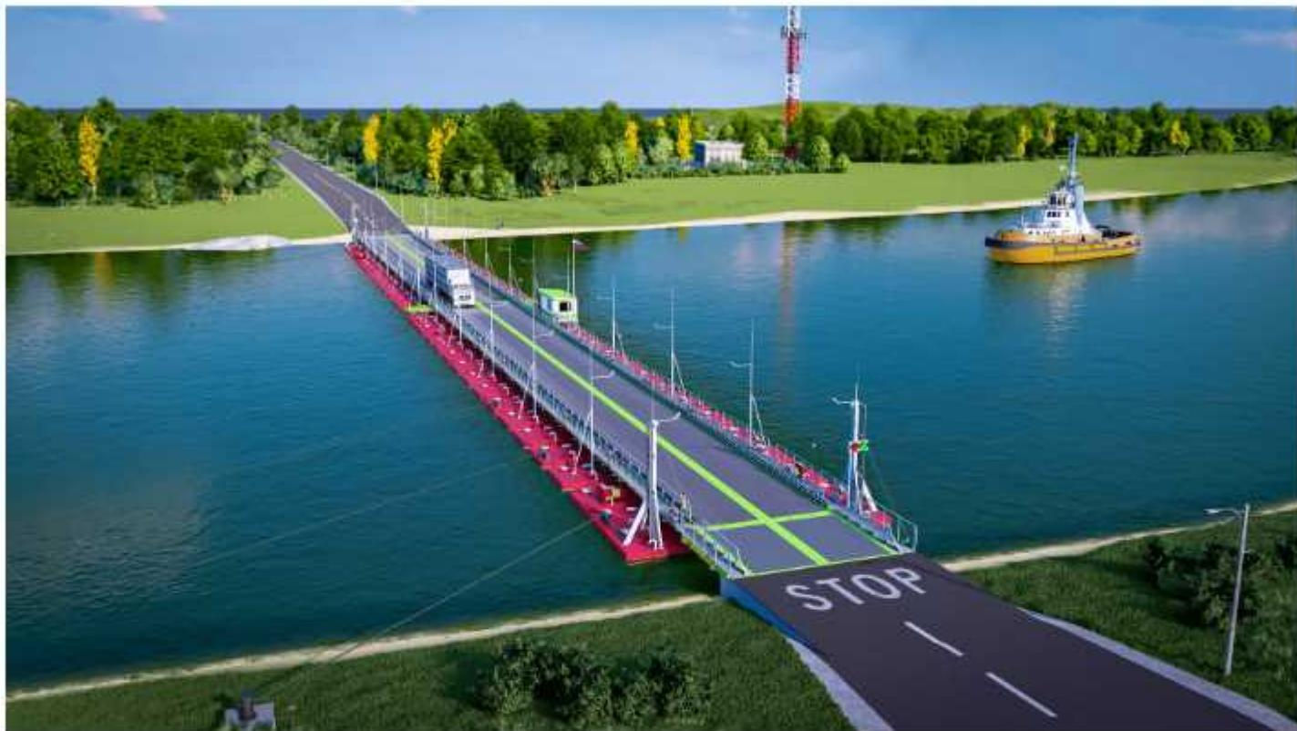
**Архитектурно-конструктивный тип** – секционно-разборное сооружение понтонного типа, состоящее из двух звеньев, одного берегового левого и одного выводного правого. Каждое звено состоит из отдельных плавучих понтонов, объединенных между собой верхним пролетным строением.
